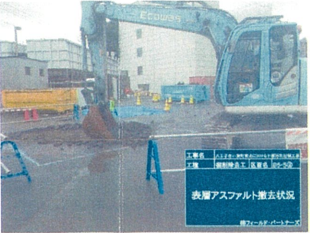
【アスファルト撤去状況】
