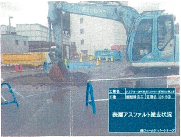
【アスファルト撤去状況】
