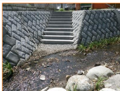
水路の親水整備
