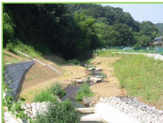
湯殿川整備（西明神橋上流）
