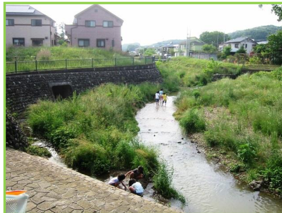
谷地川整備（宮下橋下流）
