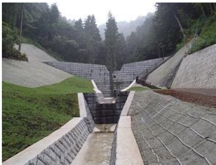
中の沢砂防堰堤（裏高尾町）
