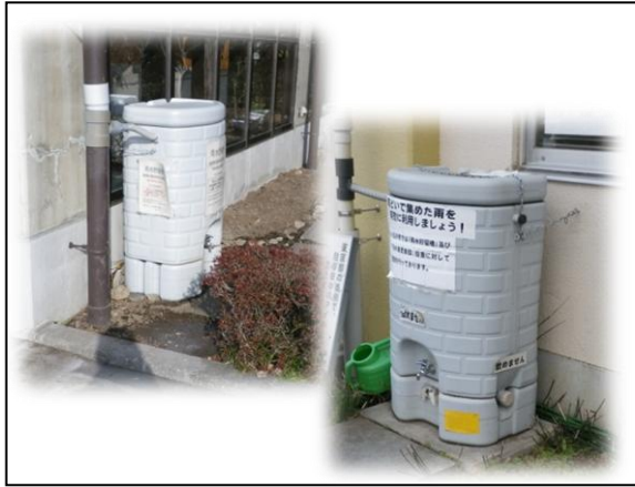
雨どい設置型（雨水貯留タンク）
