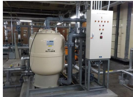
ろ過装置（B階機械室）
