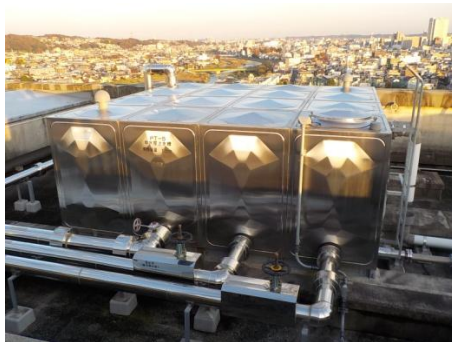
屋上中水槽（東側）
