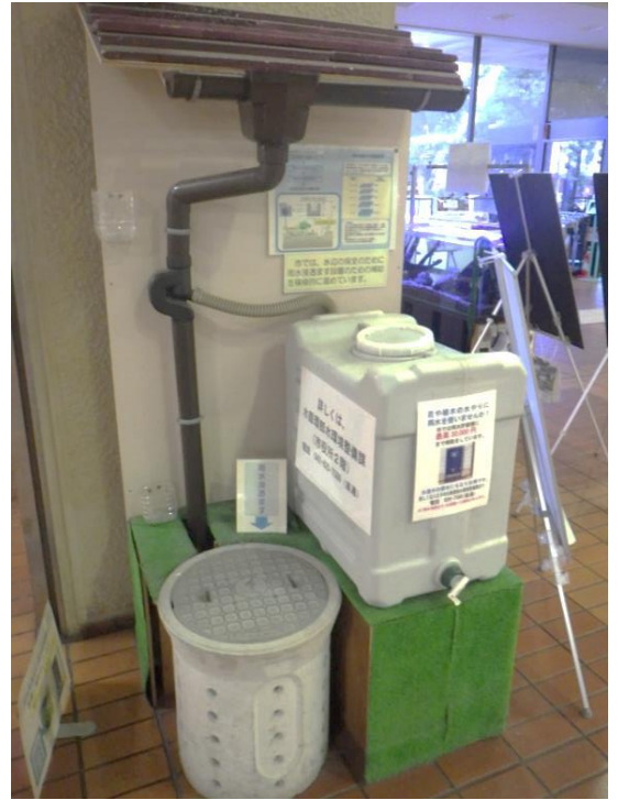
市役所本庁舎に展示している 雨水浸透ます(左下)と雨水貯留槽(右)
