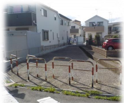
改修前の水路
