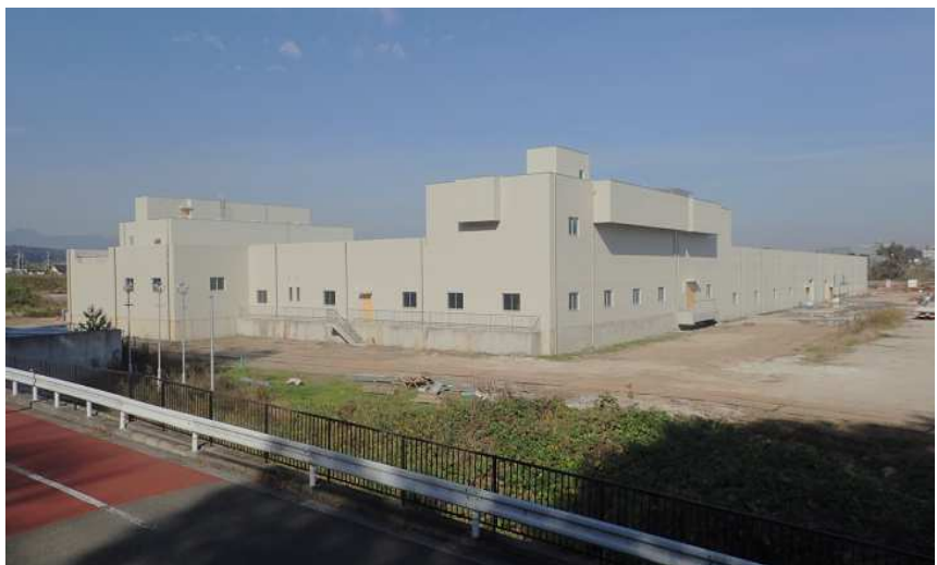
増設した八王子水再生センター水処理施設(5-1系)
