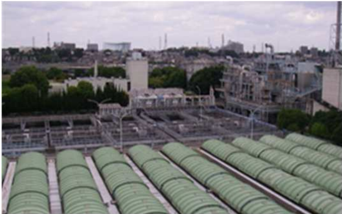
八王子市北野下水処理場 (昭和 44 年稼働)
