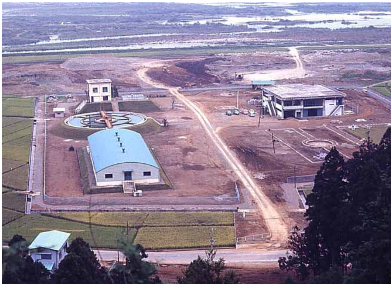
工事中の高月浄水場
