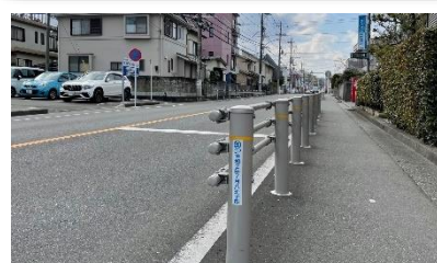
▲整備したガードレール
