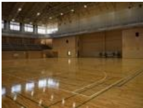
既存施設の計画的に修繕
