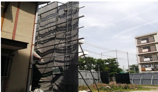
単管養生足場
