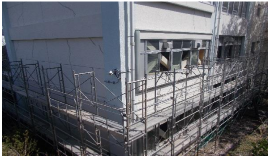
枠組養生足場
