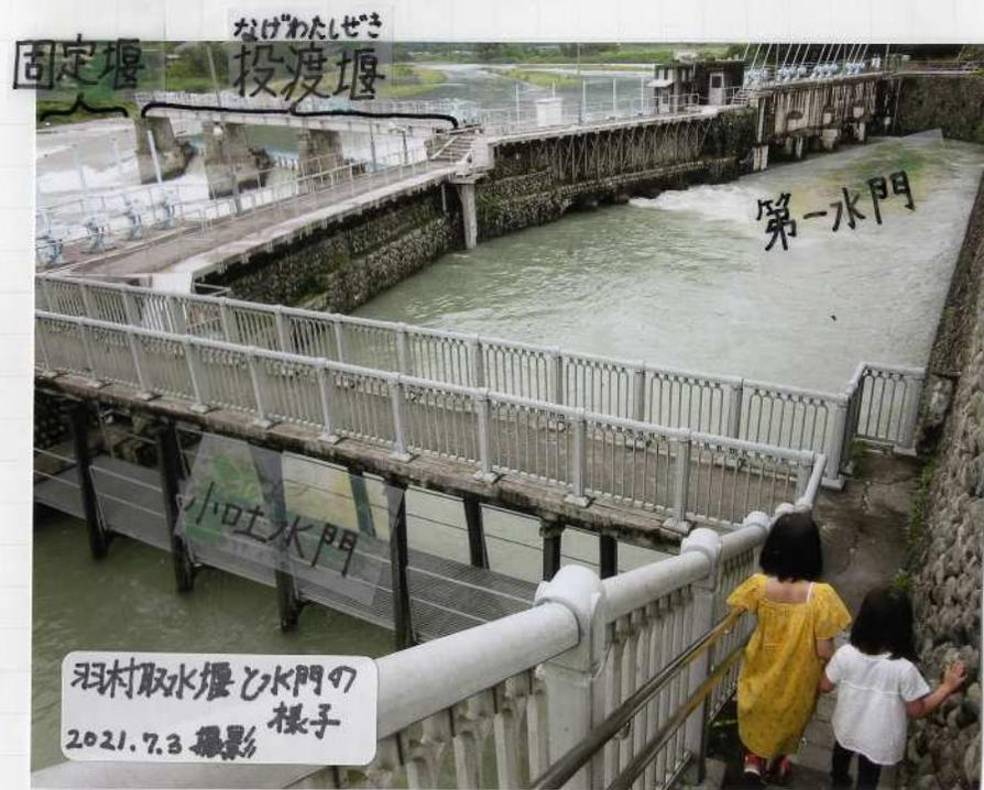
投渡堰と固定堰で堰き止められた多摩川の水は、第一水門で玉川上水に水を引き込むために取水されます。第二水門で水の水量調整を行い、水路へと流します。
