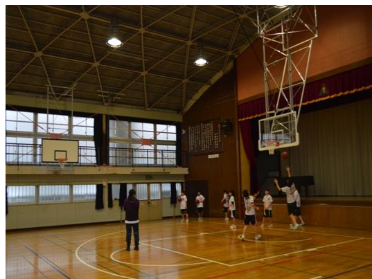
▲ バasketゴールなどの非構造部材を耐震化
