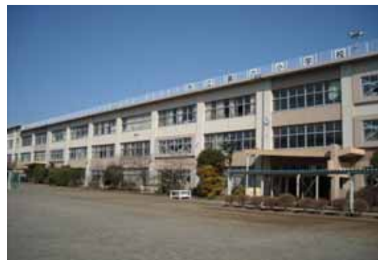
いずみの森小中学校 平成24年4月開校
