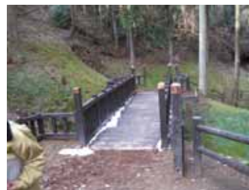
改修した古道橋(史跡八王子城跡)
