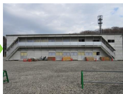
仮設現場事務所（完成）
