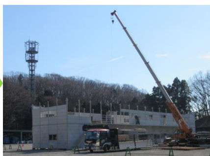
設置途中の仮設現場事務所
