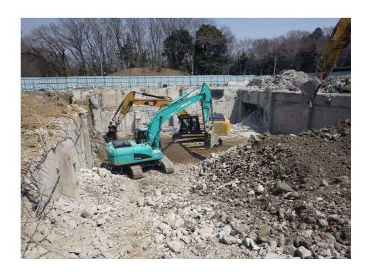
地下部分の解体作業では、大型ブレーカーやコンクリート圧砕機を使用して、壁や床の鉄筋コンクリート構造物を壊しました。
