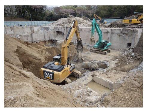
下の写真は、地下1階部分の約3分の2について解体が完了した状況です。解体が完了した部分について、市監督員の立会い確認を実施しました。
