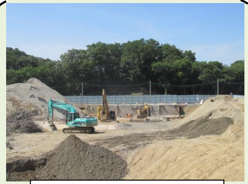
地下構造物の解体状況
