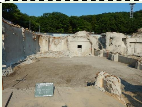
埋め戻し完了後
