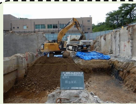
汚染土壌の除去作業中
