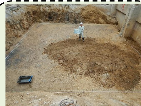
汚染土壌の除去後
