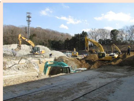
地下構造物解体作業の様子
