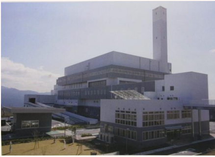
最新の焼却センター外観
