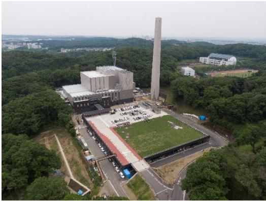
工事現場全景
