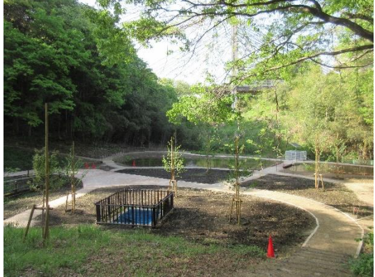
ビオトープ施工状況
