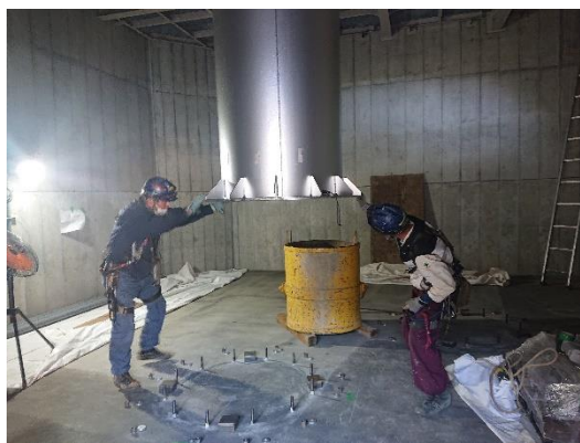
内筒設置状況
