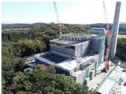
工事現場全景
