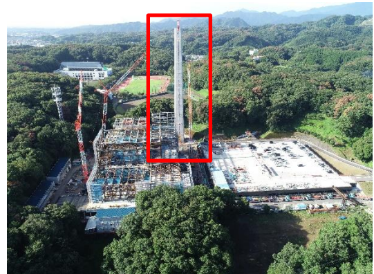
7月(躯体完成時)
