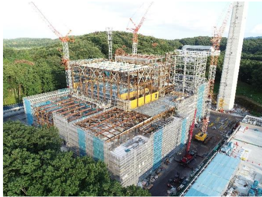
工事現場全景
