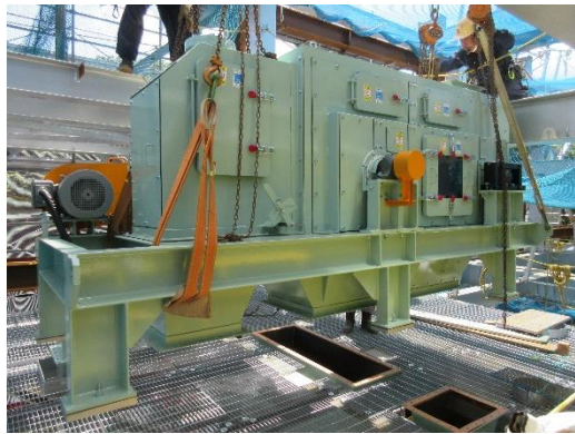
非鉄選別機据付
