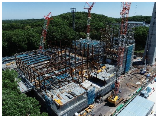
工事現場全景
