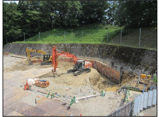
煙突基礎工事
