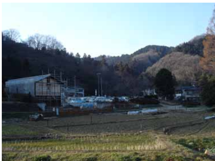
南側より計画地を見る
