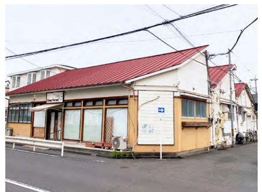
織物のまちの面影が残るのこぎり屋根の建物
