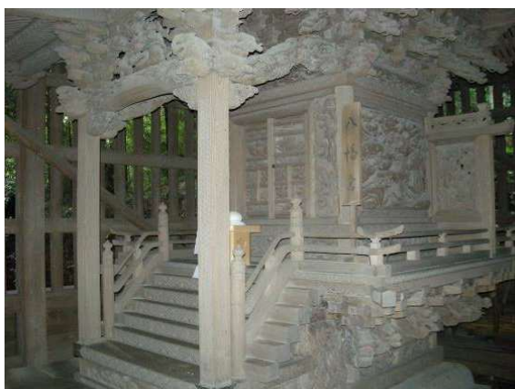
(ア) 諏訪神社社殿（八幡神社）
