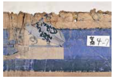
写真58 初期の幕4の破損部分
