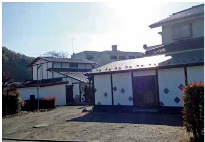
西川古柳座外観 左よりカシラ部屋、稽古場、衣裳部屋 平成28（2016）年12月2日撮影
