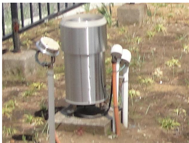
市設置の雨量計（南大沢雨量計）
