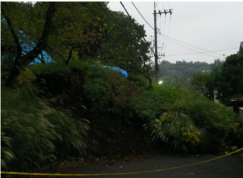
大塚の土砂崩れ状況 (提供：大塚団地自治会防災会)
