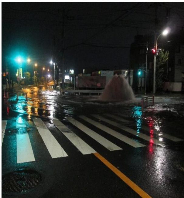
多摩大橋南交差点のマンホールから冠水
