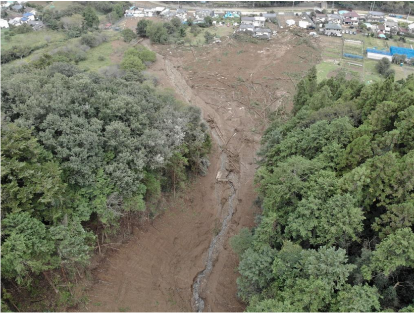
ドローン積載カメラからの撮影による 上恩方町の土砂災害状況 (提供：八王子市消防団)
