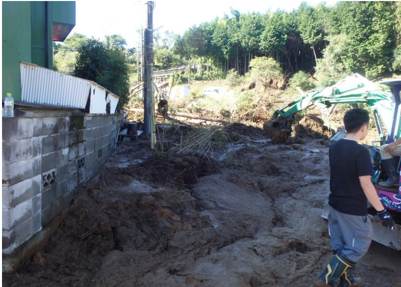
下恩方町土砂災害 聖パウロ学園周辺土砂流出
