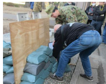
自衛隊式積み土のう工法
