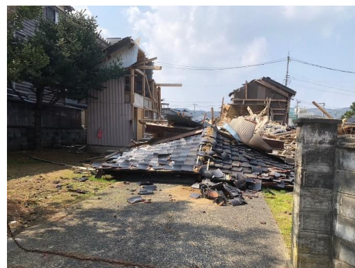
(輪島市家屋崩壊の様子)
