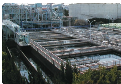
跡地の活用についての基本構想が策定されている旧北野下水処理場
