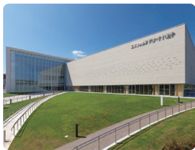
PFIにより整備した総合体育館 (エスフォルタアリーナ八王子)
