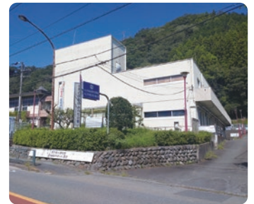
8年3月31日で廃止となる恩方老人憩の家（恩方事務所2階）
