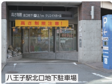
消防設備等の更新工事を行い、さら に安心して利用しやすい駐車場に
