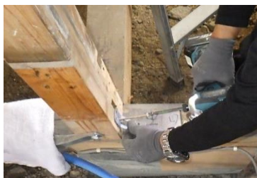
耐震金物取付
