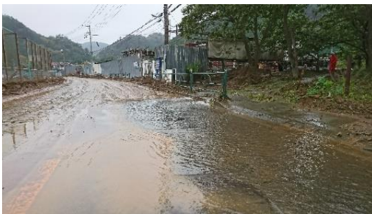
令和元年東日本台風による被害事例
