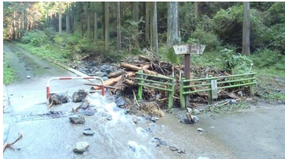
土砂・流木による水路詰まり
