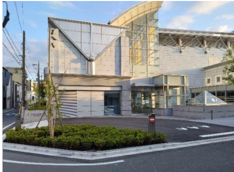
新設した車寄せ(建物北側)
