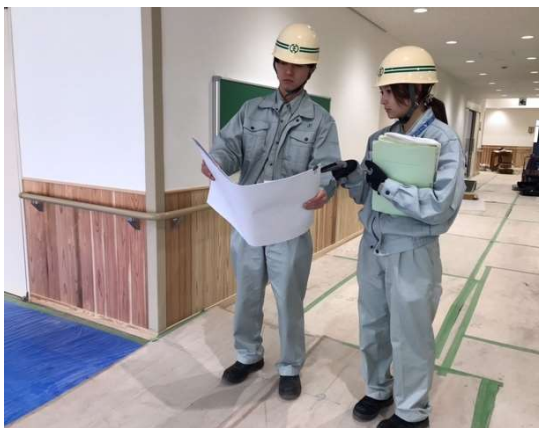
工事中の現場での確認作業です。
