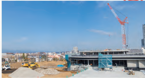
▲建設中の様子
