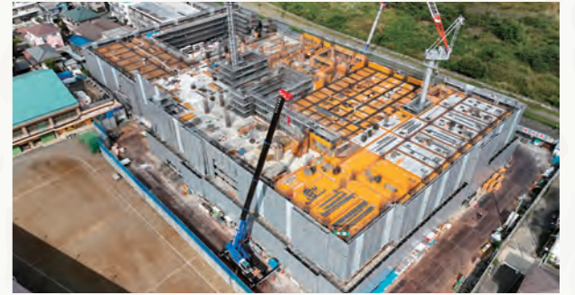
▲建設中の様子
