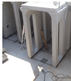
小宮駅前貯留浸透施設
