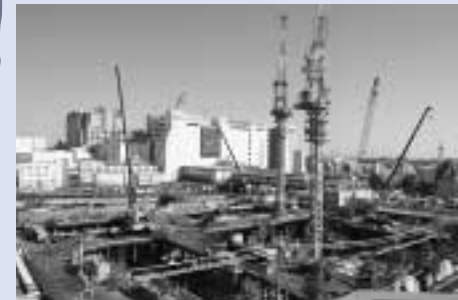
▲八王子駅南口地区再開発事業が 着工(写真は11月撮影)
