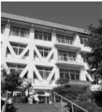
▶急ピッチで進む耐震化改修(写真は由木西小)
