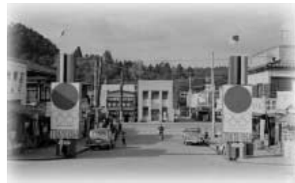
高尾駅前には歓迎塔も設置されて
