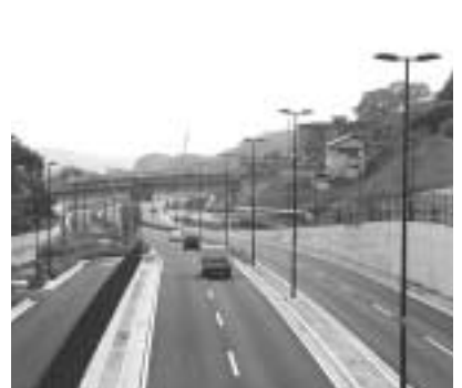
整備が進む新滝山街道(戸吹町)
