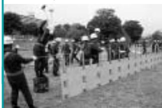
水害に備えた鋼板防護工法も
