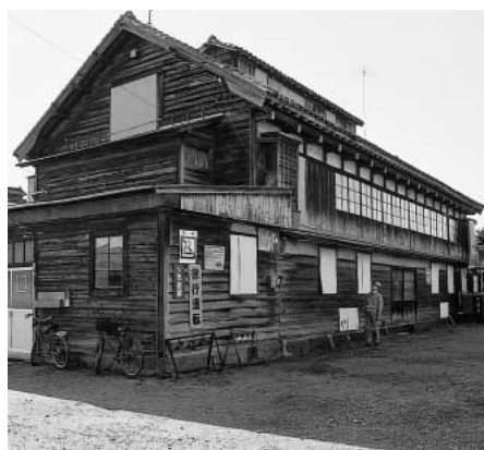
かつての蚕室は寮となつて
