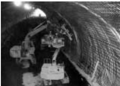
▲19年春の完成をめざして工事が進むつつじヶ丘トンネル
