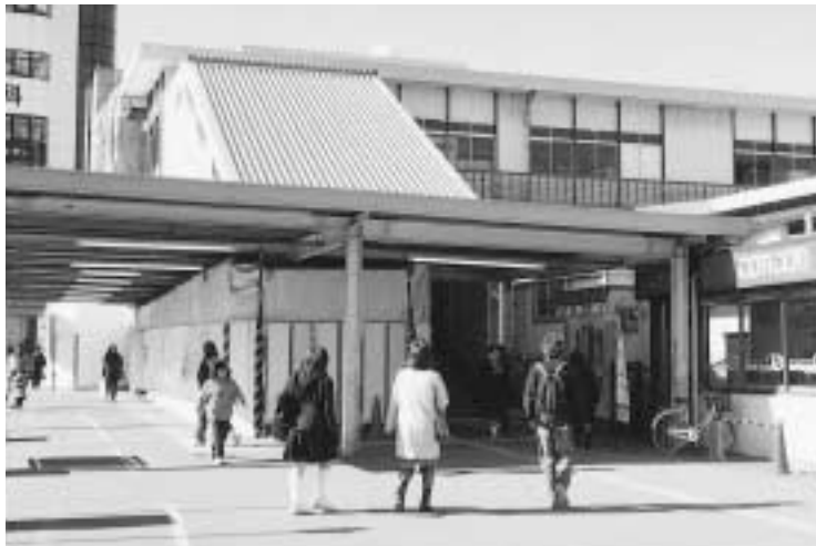
3月の運転開始に向けて工事の進む西八王子駅
