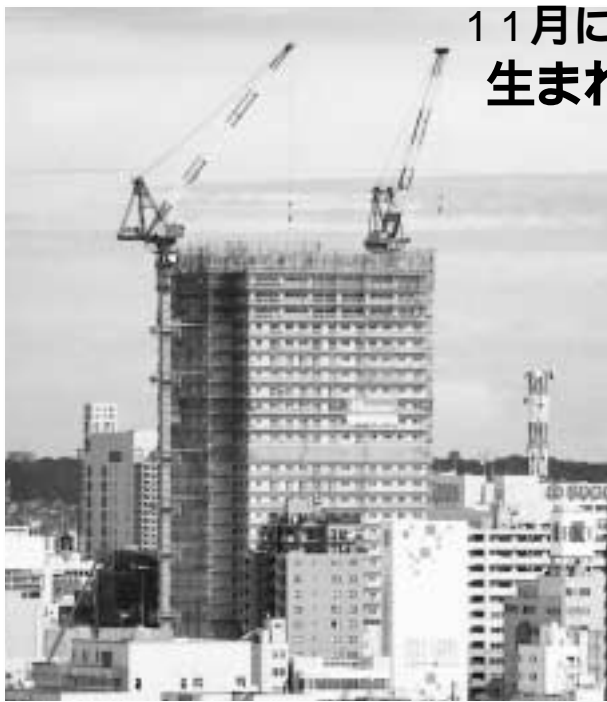
着実に工事の進む八日町再開発ビル
